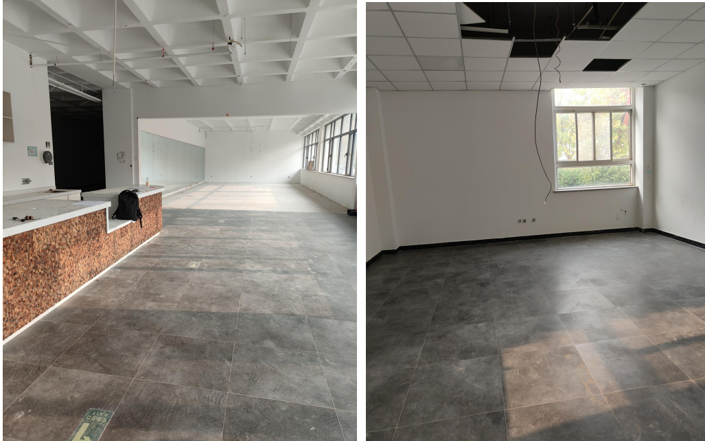
图 2-4 本项目租用的房屋现状
